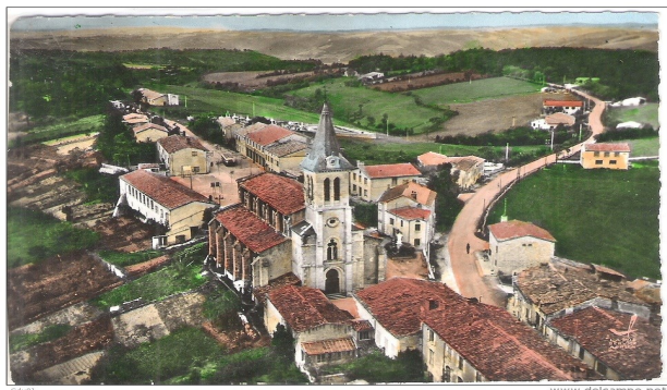
Lacrouzette avant le début des travaux
