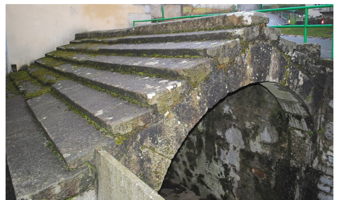
Le lavoir du Théron date du XIII e siècle. A noter la belle toiture en voûte toute en granit.
