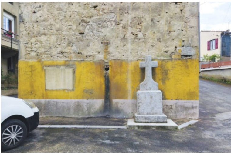
Dépose de la croix de Campselves pour un petit lifting. Elle reprendra sa place une fois nettoyée.
