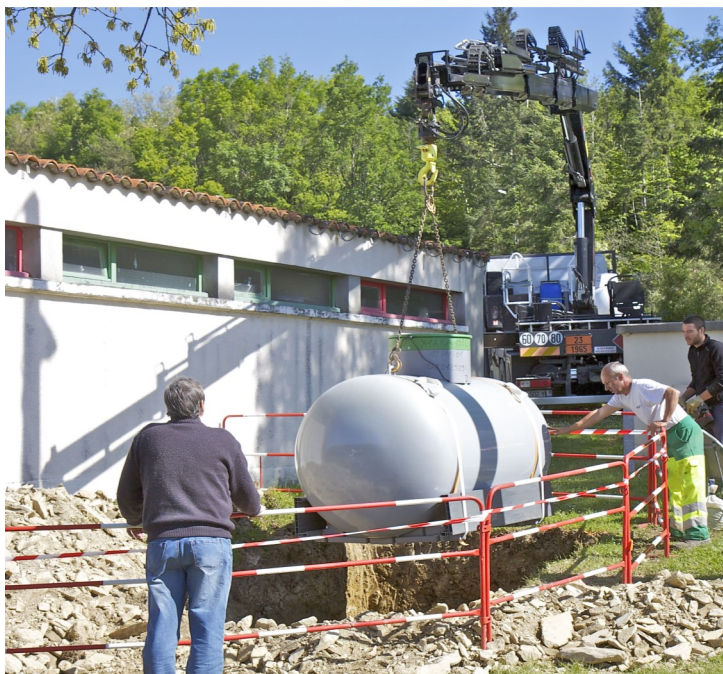
Mise en place d'une cuve à gaz pour alimenter la nouvelle chaudière des sanitaires de la Bessière.
